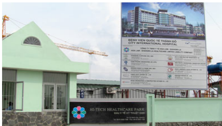
Bệnh viện quốc tế Thành Đô tại Khu y tế kỹ thuật cao Bình Tân đang được xây dựng. Ảnh: TG. LÂM
